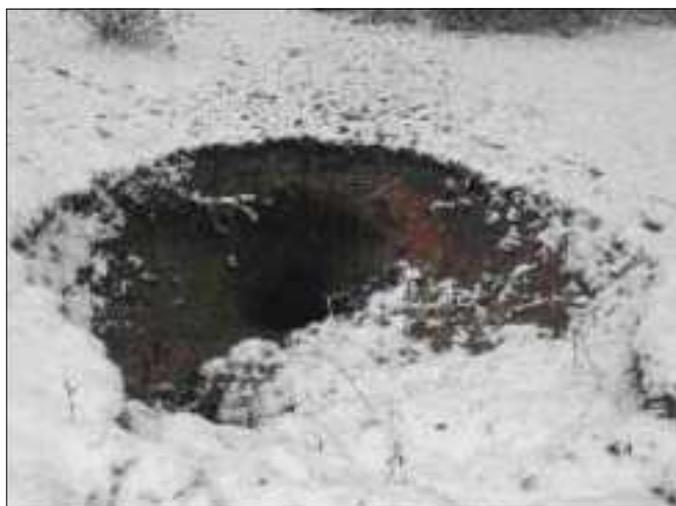
**Figure 13** : Effondrement d'une zone sous-cavée par suffosion [Source : BRGM]
