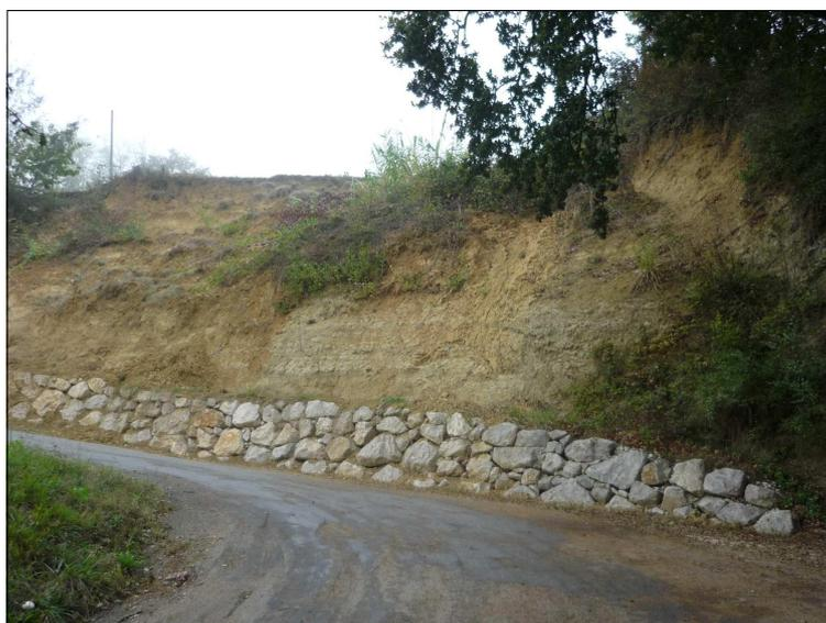
**Figure 34** : Mur de soutènement le long du chemin des Arènes [Source : IMS<sub>RN</sub>]
