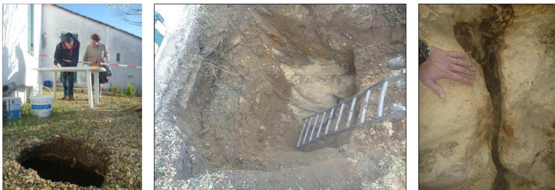
**Figure 12** : Apparition d'un fontis à LATRESNE (Gironde) lié au déboufrage d'une fissure karstique (visible au fond derrière l'échelle) ayant entraîné les terrains superficiels [Source : Bureau des Carrières de Gironde]
