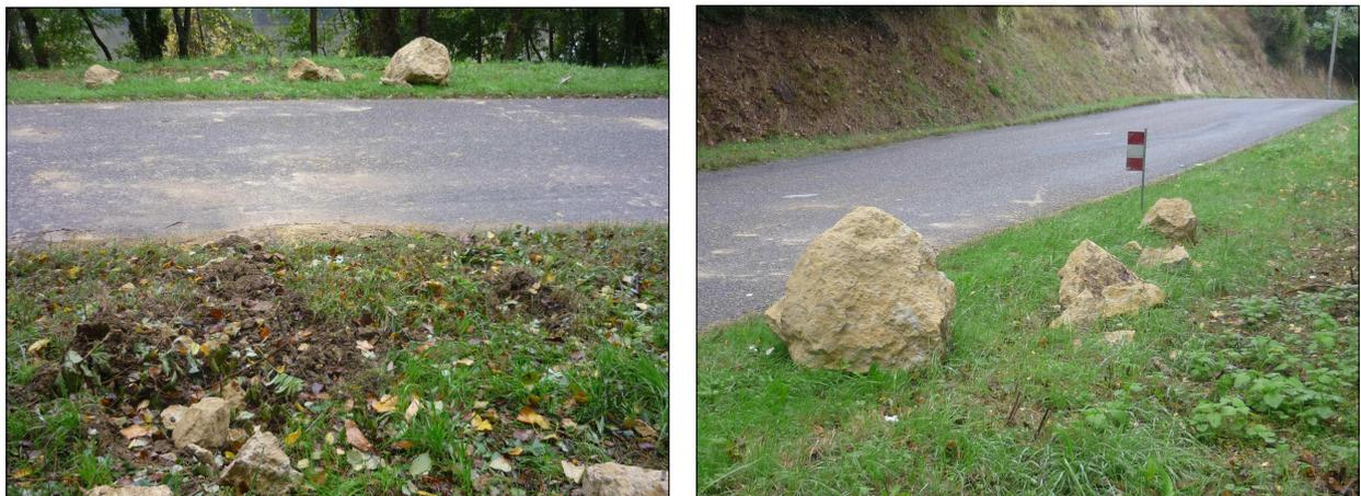
**Figure 22 :** Impact des blocs sur l'accotement de la route (à gauche) et éléments les plus volumineux de l'autre côté de la route (à droite) [Source : IMS<sub>RN</sub>]
