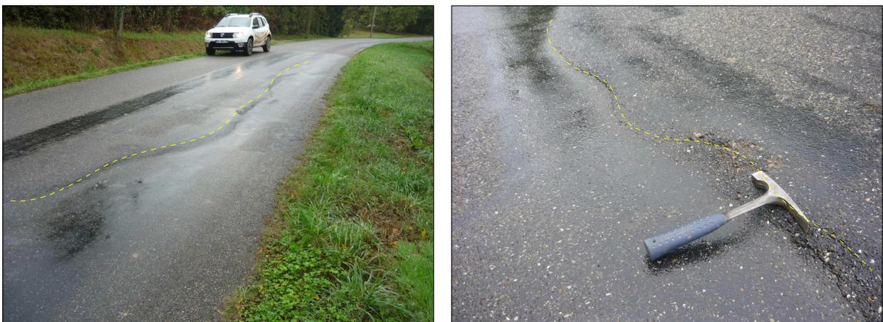
**Figure 26 :** Fissuration et affaissement de la chaussée de la RD 101 dans le méandre du Tarn [Source : [IMS<sub>RN</sub>](#)]
